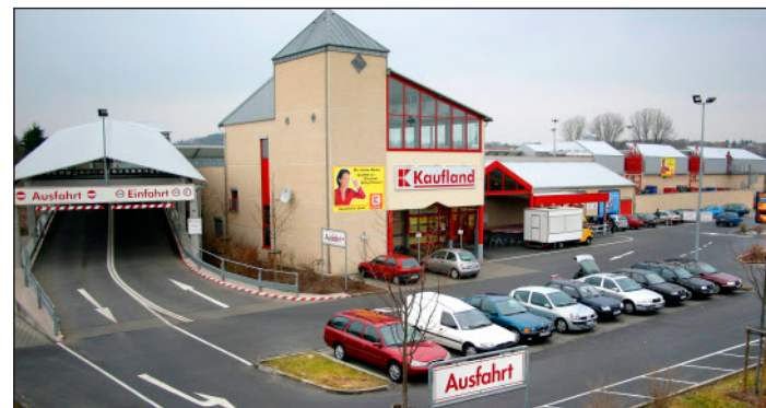
Einen Platz auf der grünen Wiese wie hier in Treysa würde ein Kaufland-Warenhaus in Stadtallendorf nicht haben. Dort könnte es zentral an der Straße des 17. Juni entstehen. (Archivfoto)
